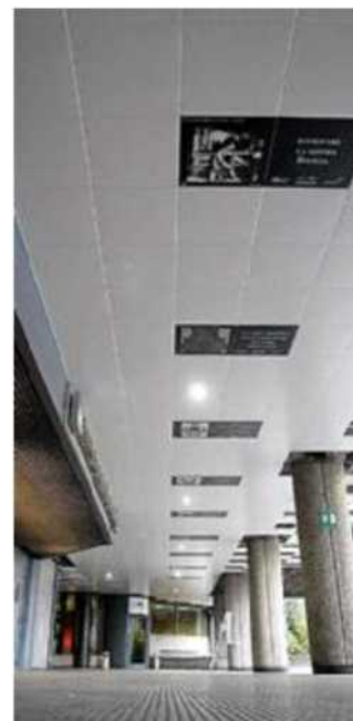
Il passaggio pedonale rinnovato
